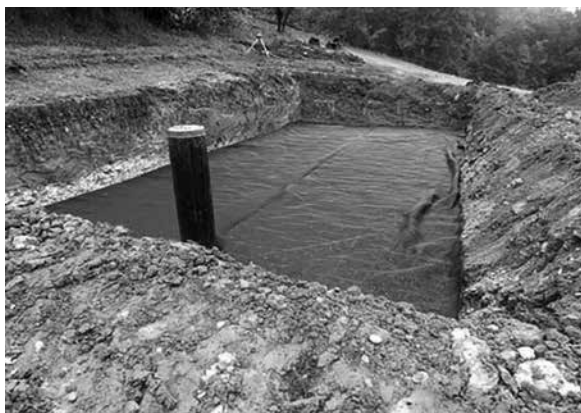
Figura 1.1 – Esempio di scavo a cielo aperto
